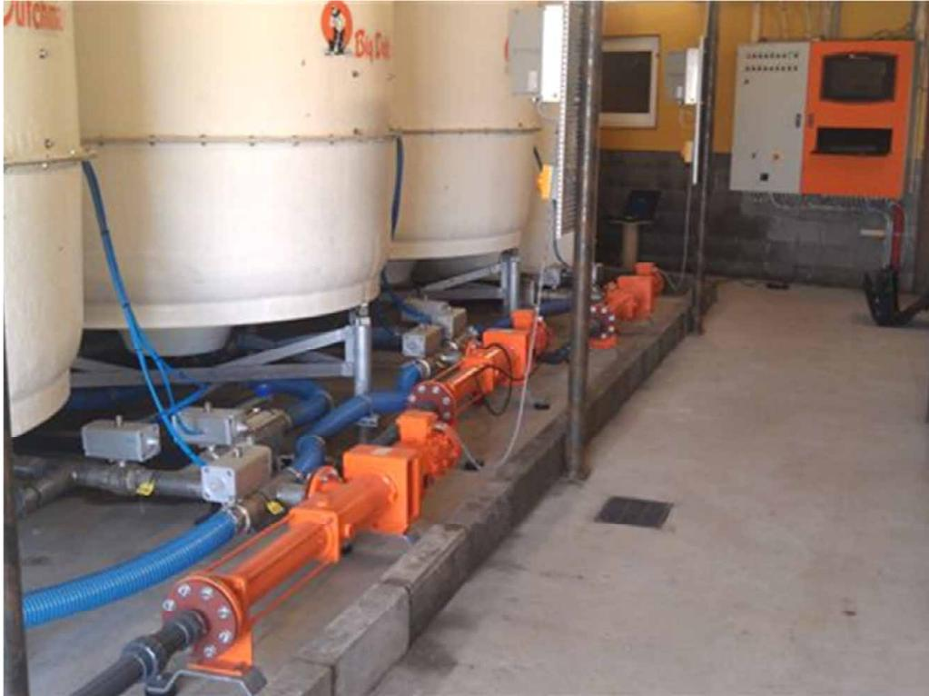
Foderpumpen er hjertet i ethvert vådfodringsanlæg, derfor er det vigtigt at vælge den rigtige pumpe. Der er forskellige behov alt efter valg af fodermidler og staldstørrelser og dermed rørstrengenes længde samt udfodringsmængder.
