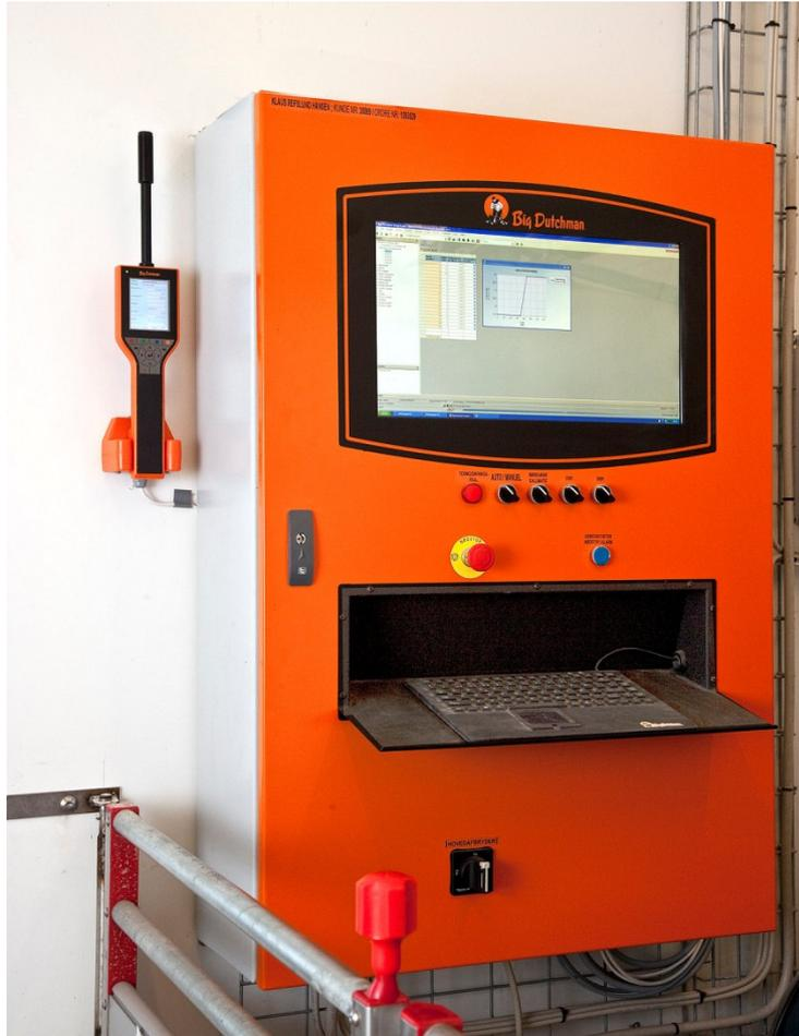
Til ethvert fuldautomatisk Big Dutchman fodringsanlæg hører en MC99NT-3 computer, med panel pc, der styrer alt fra vådfodring og ESF til computerstyret tørfodring og møllesianlæg.
