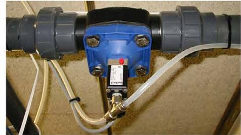
**Foderventilen** er en membranventil, der lukker ved med trykluft. På foderventilen er monteret en magnetventil, der sørger for lufttilgangen til ventilen. Lufttilgangen er med snaplåse, således at eventuelle utætheder på luftledning eller membran hurtigt kan lokaliseres og udbedres.
