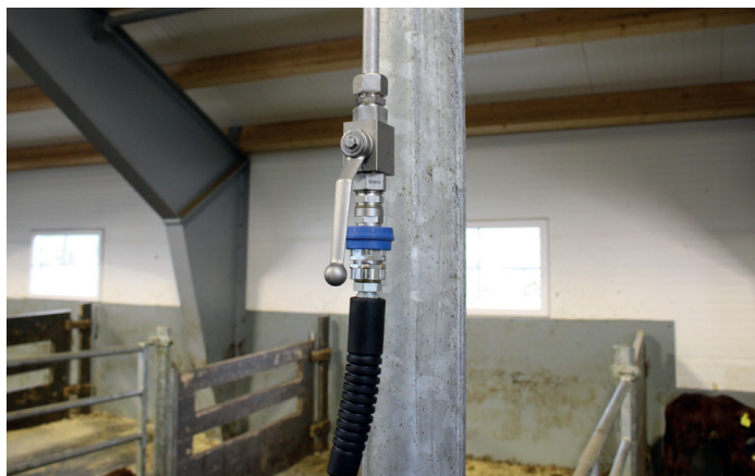
Rørgate med kulekran og hurtigkobling.
